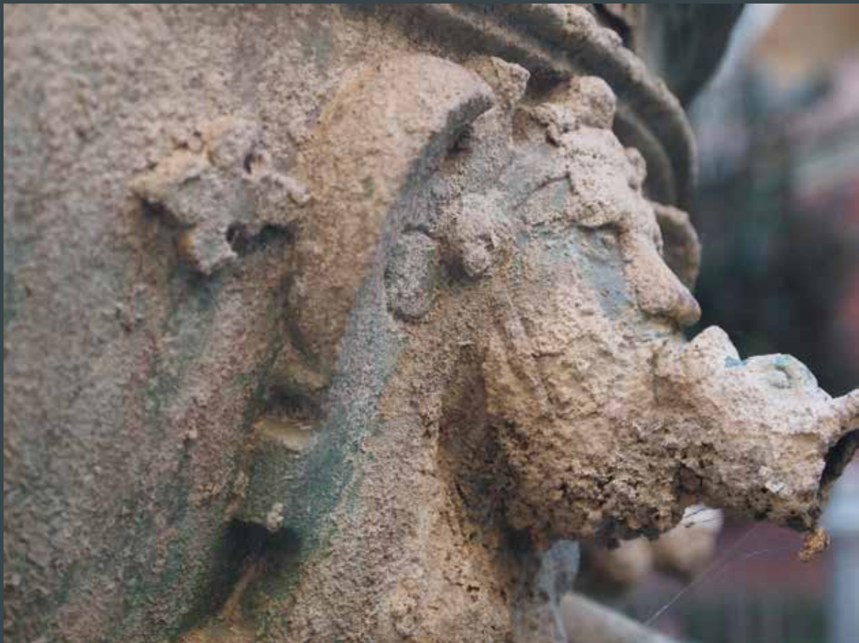
Figura 29. Costra de carbonatación en un caño antropomorfo del surtidor central. (foto Perla/Peña).
