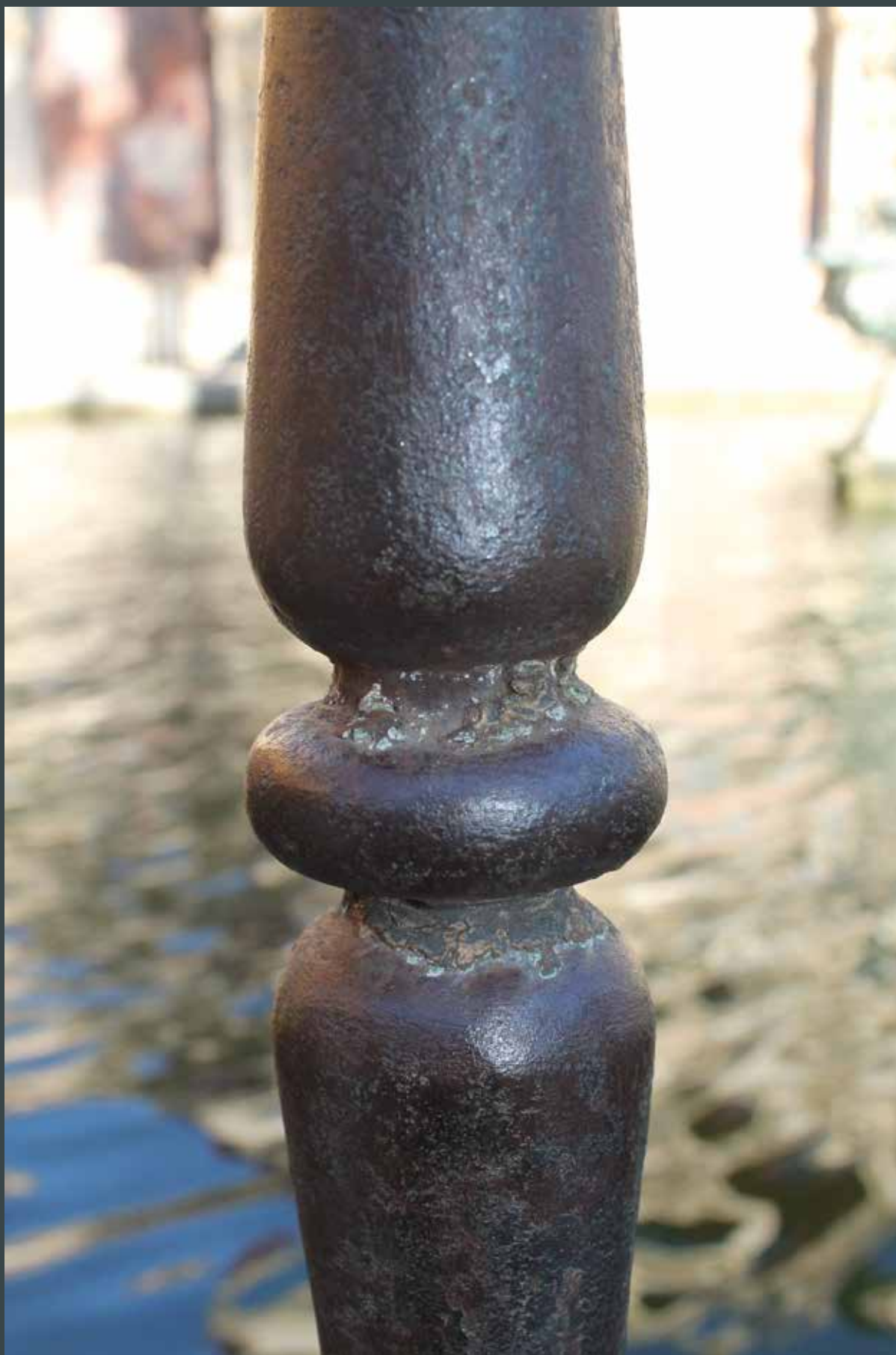
Figura 31. Detalle de vestigios de pintura original bajo otros estratos de revestimiento posteriores (lado Oeste). (foto Perla/Peña).
