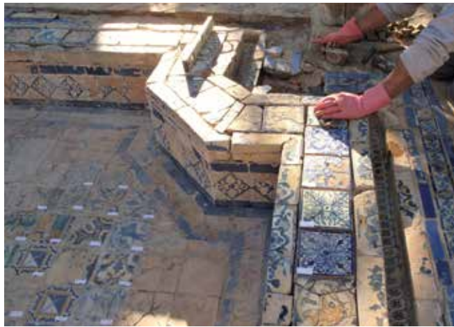
Figura 34. Fuente oeste, cuadrante SW. Eliminación de sellados de cemento en las juntas. Vaciado y limpieza de juntas del material cerámico, y proceso de montaje de la cenefa perimetral. (Crest Arte)
