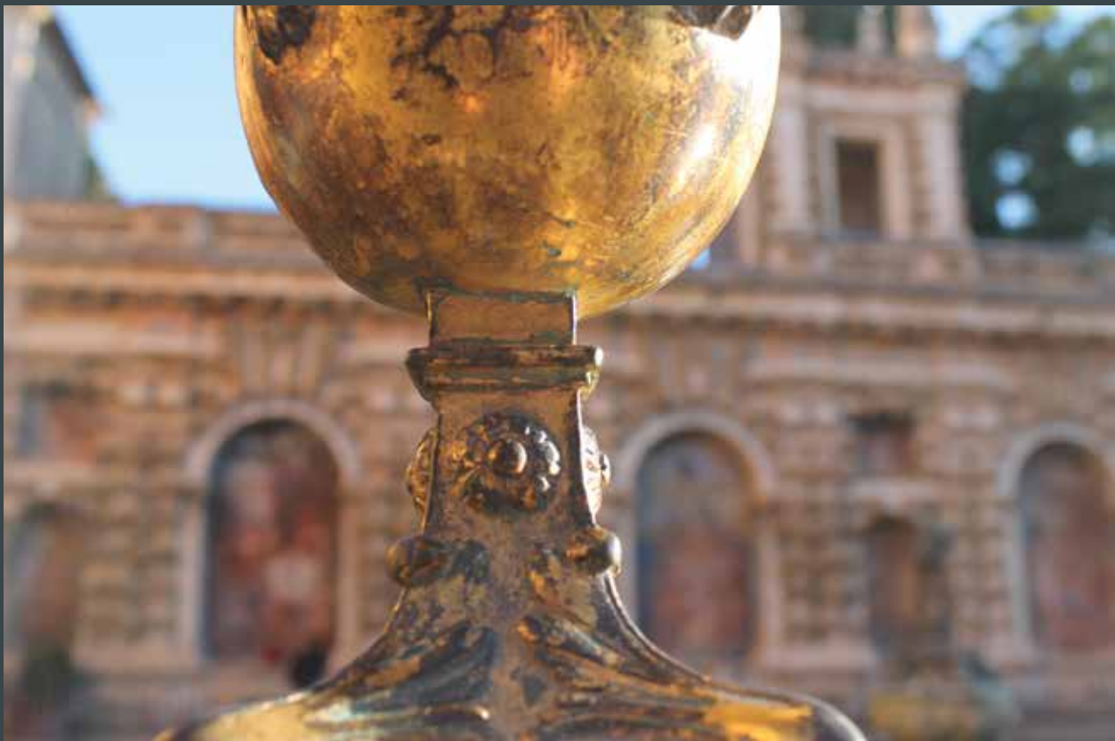
Figura 23. Presencia de cloruros en la bola del pilar nº XVI en el lado Oeste (foto Perla/Peña).
