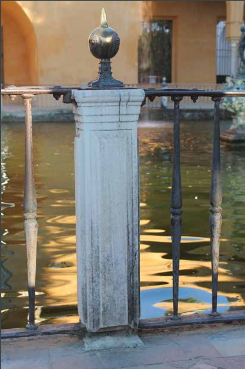
Figura 12. Basa completamente socavada en el pilar n° XI (foto Perla/Peña).
