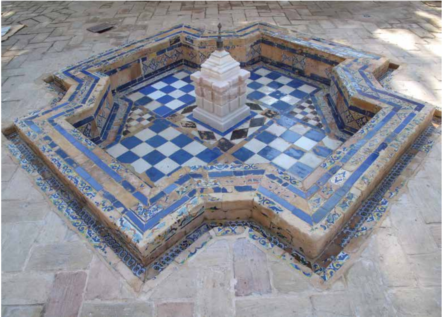
Figura 46. Fuente este, una vez limpiada, sellada e hidrofugada. (Crest Arte)
