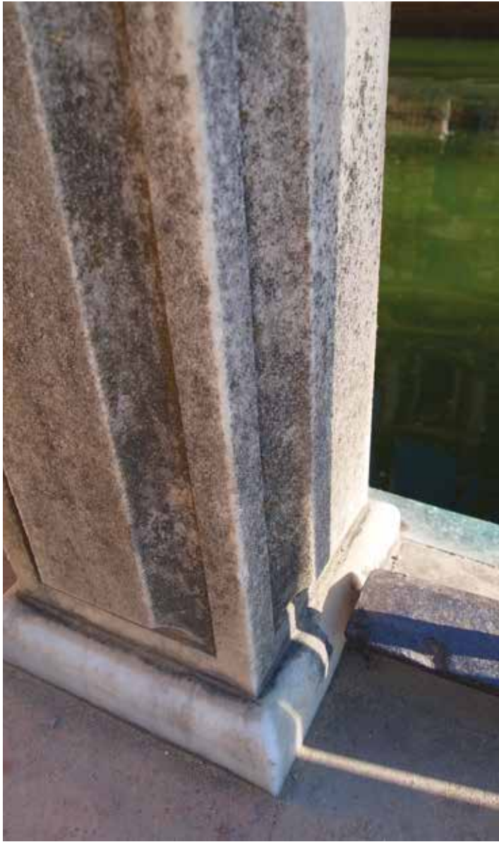
Figura 6. Pletina original serrada para la instalación de uno de los pilares de nueva factura (n° XV) (foto Perla/Peña).
