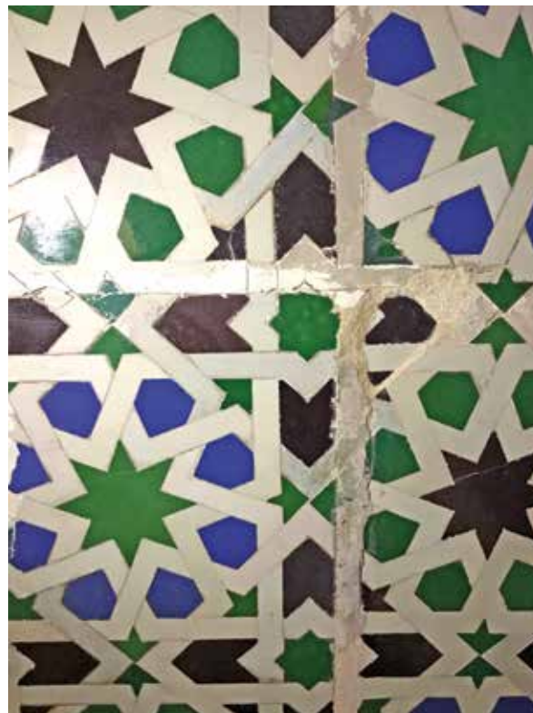
Figura 9. Reintegraciones por pérdida de aliceres realizadas con mortero de cal y yeso muy deterioradas en la actualidad.
