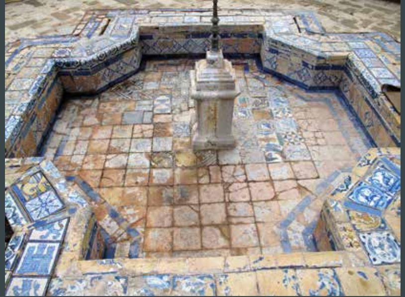
Figura 40. Fuente oeste. La fuente una vez eliminadas las costras y en proceso de eliminación de juntas de cemento. Visión general del despiece actual. (Crest Arte)
