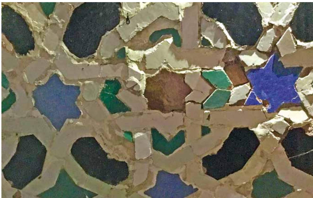
Figura 10. Fragmento de alicatado que presenta un deterioro extremo como consecuencia de las humedades de capilaridad del muro que lo sustenta.
