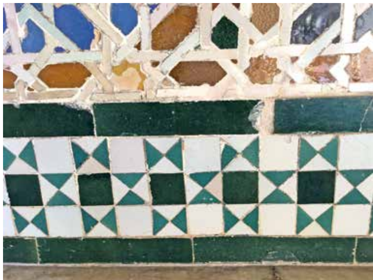
Figura 1. Detalle de plinto repuesto en el Patio de las Doncellas.
