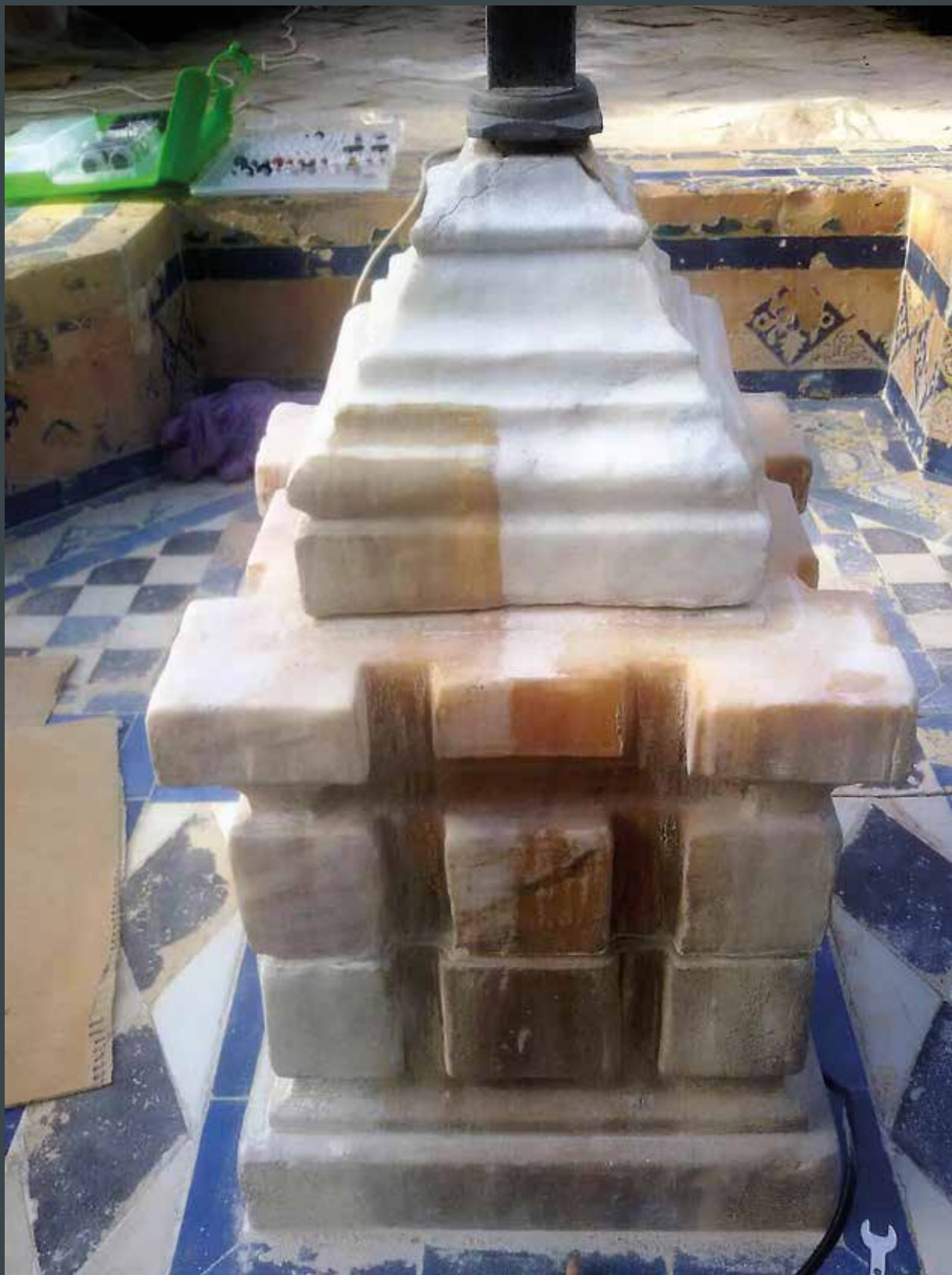
Figura 45. Fuente este. Proceso de limpieza mecánica y química del pedestal marmóreo. (Crest Arte)
