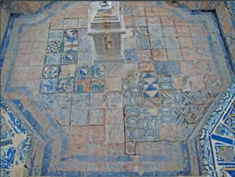
Figura 39. Fuente oeste. Estado tras la eliminación laboriosa de las costras y de los cementos en las juntas. Situación y estado del despiece del fondo del vaso, compuesto por multitud de piezas variopintas, añadidas sin respeto alguno por la composición original. Proceso de rehundido y limpieza de juntas. (Crest Arte)
