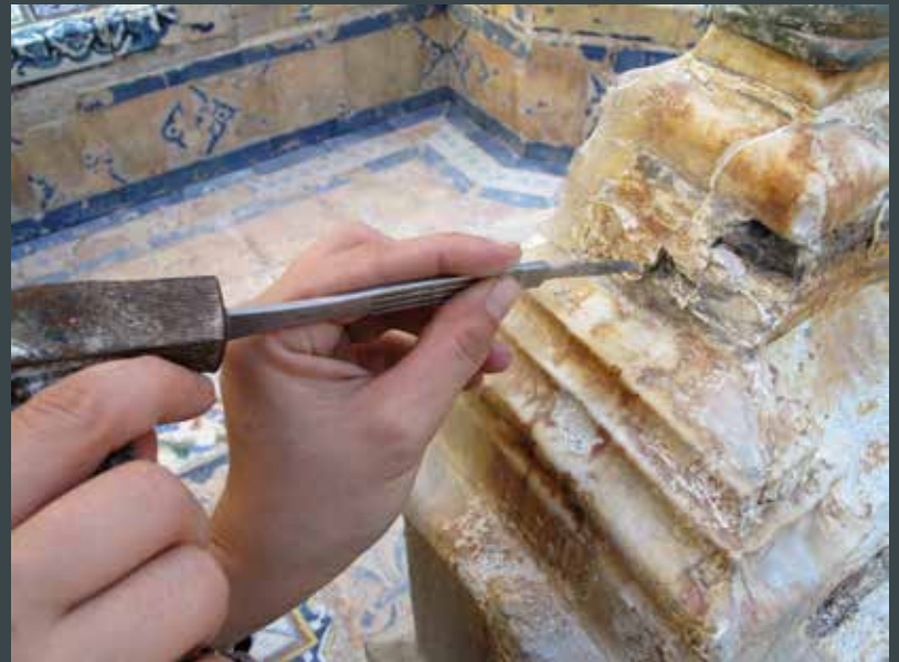
Figura 41. Fuente oeste. Proceso de eliminación mecánica de zonas reconstruidas del pedestal, ejecutadas con cemento portland y gris. (Crest Arte)
