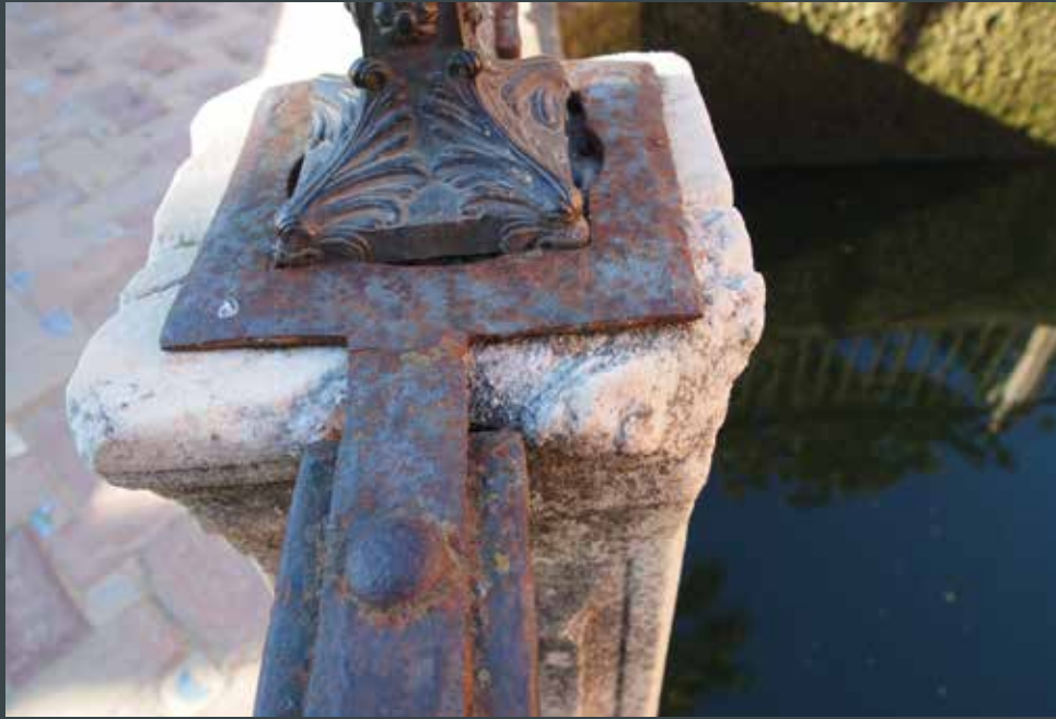
Figura 18. Meteorización y degradación matérica del mármol en la cima del pilar nº XI en el lado Sur (foto Perla/Peña).
