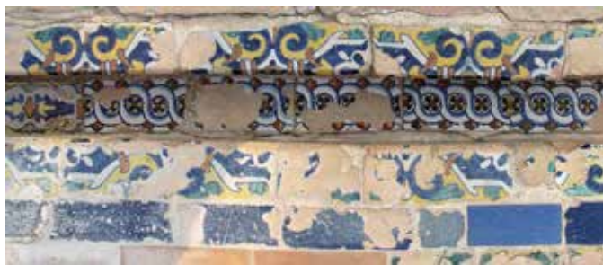
Figura 8. Fuente este. El canal exterior conserva algunos alizares, adeseras y verduguillos primitivos, aunque con abundantes pérdidas de vidriados. (Crest Arte)
