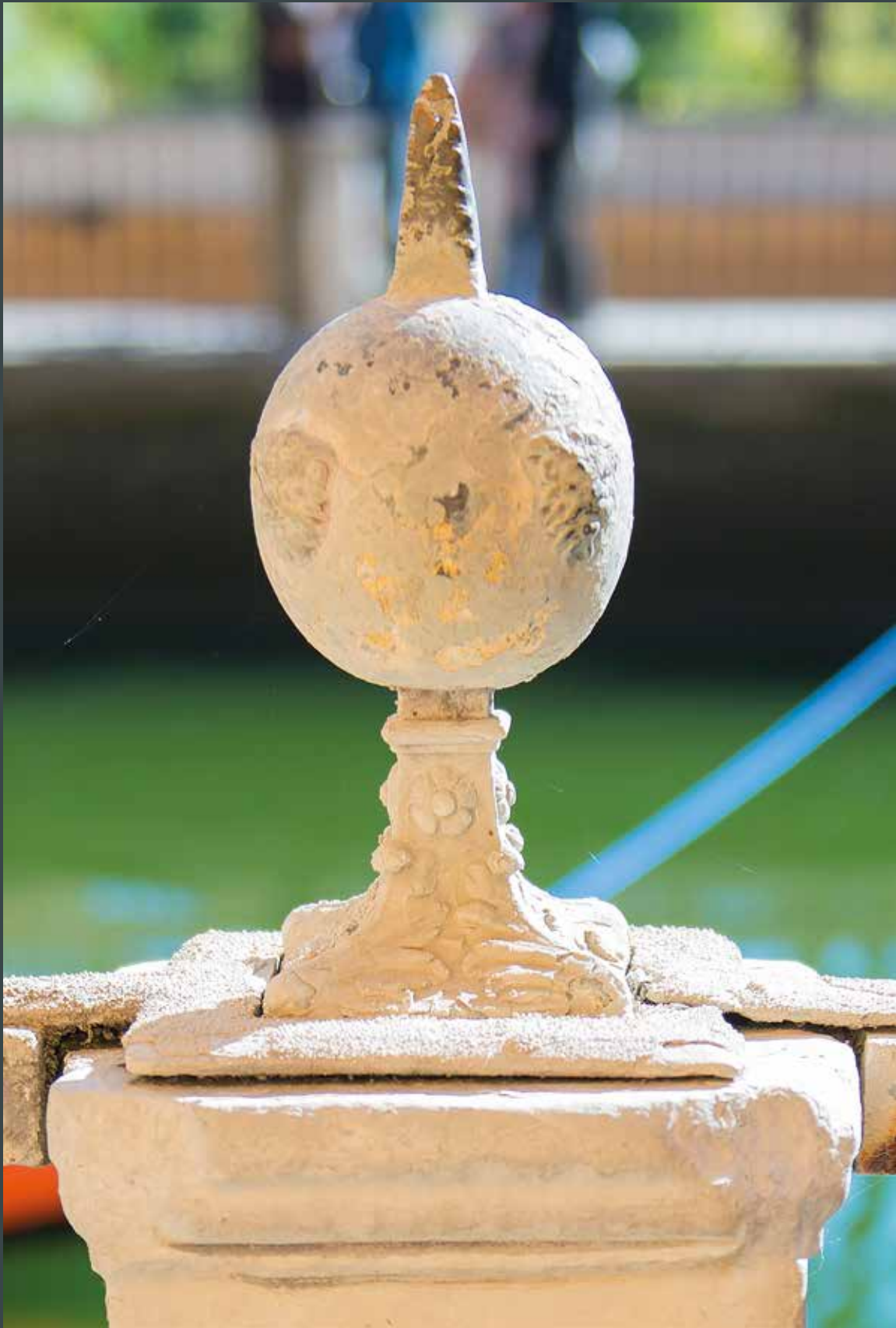
Figura 16. La bola del pilar nº XXII y los materiales adyacentes completamente cubiertos por la película carbonática que genera las salpicaduras del chorrón.(foto Nacho Pérez).
