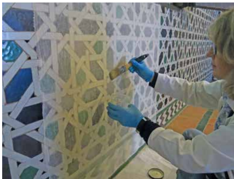
Figura 6. Actividad de emergencia alicatados. Rocío Campos.
