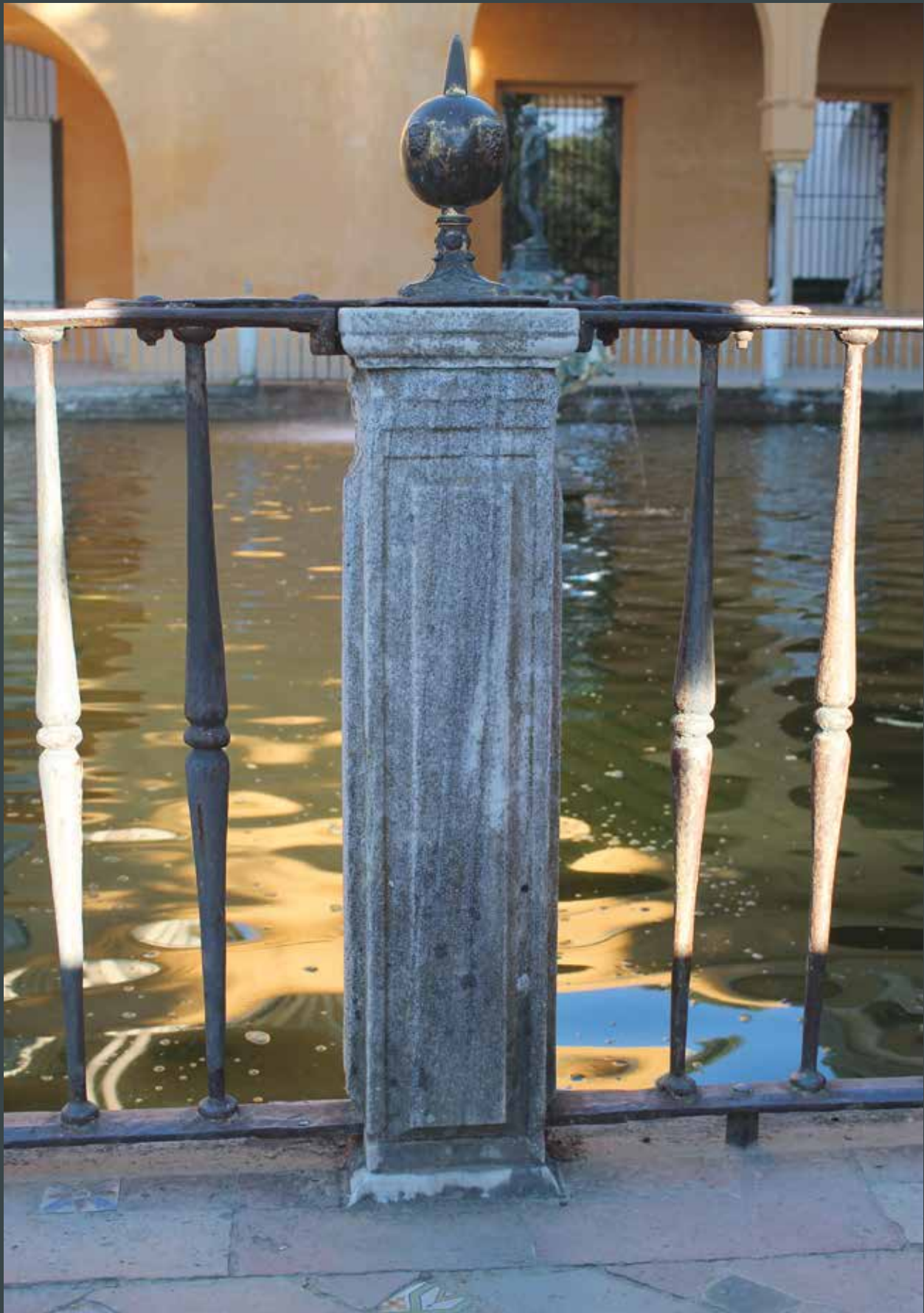
Figura 27. Biocosta en el pilar nº X en el lado Sur. (foto Perla/Peña).
