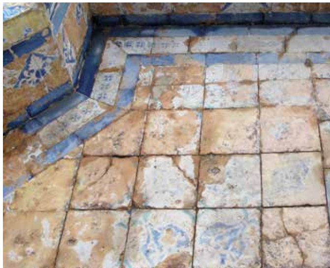
Figura 7. Fuente oeste. Vestigios de la azulejería primitiva en el fondo del vaso, cenefa perimetral del suelo (verduguillos y adeseras) y paramentos internos. (Crest Arte)
