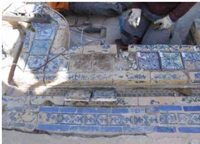
Figura 36. Fuente oeste, lado oeste. Desmontaje de la azulejería del pretil por desconsolidación de piezas. Saneado, limpieza, consolidación y montaje. (Crest Arte)
