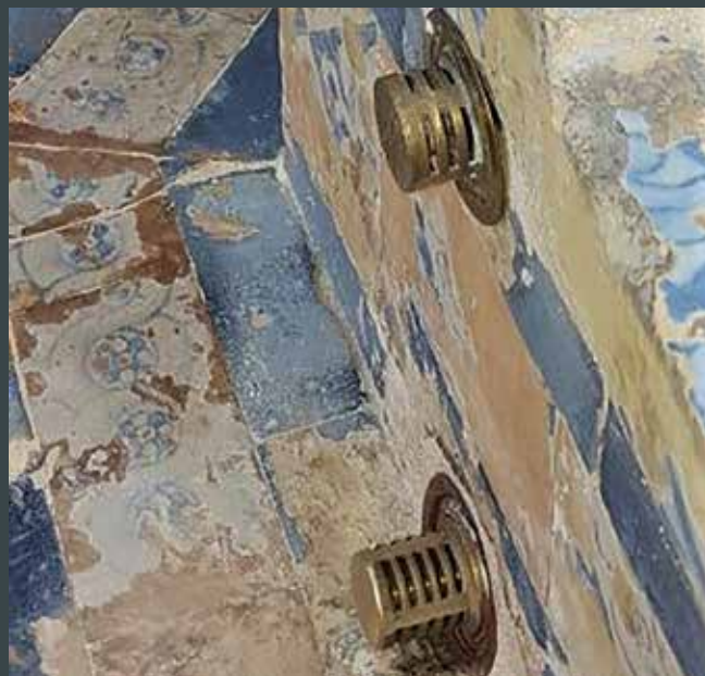
Figura 26. A las dos fuentes se les ha instalado un rebosadero que no tenía. El agujero inferior conduce el agua a la arqueta. (Crest Arte)
