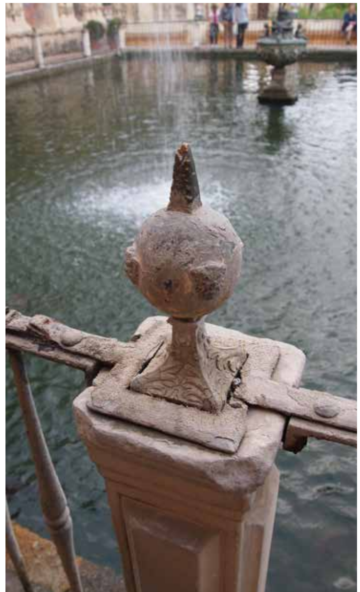
Figura 7. El chorrón y las alteraciones que produce sobre los distintos materiales (foto Perla/Peña).
