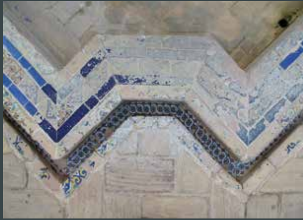
Figura 11. Fuente este. Cubriciones de la azulejería por velos y costras calcáreas. (Crest Arte)
