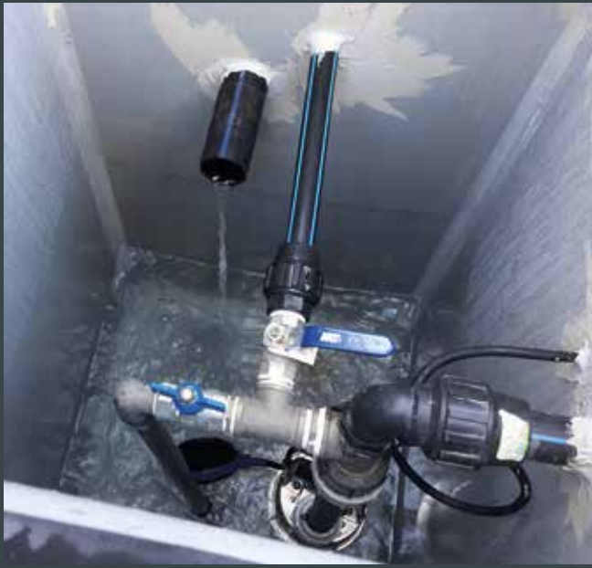
Figura 24. Arqueta de pvc con mecanismo de recirculación, semienterrada en el parterre. (Crest Arte)
