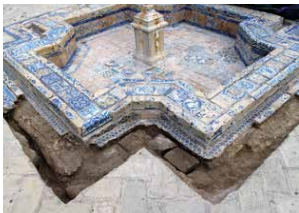
Figura 33. Fuente oeste, cuadrante SW. Desmontaje de la cenefa perimetral exterior por deformación y hundimiento del terreno. Saneado del asiento. (Crest Arte)
