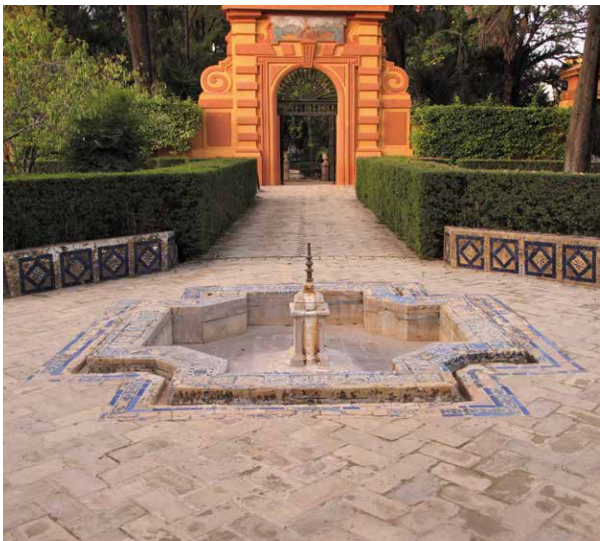
Figura 3. Estado previo a la intervención en fuente y bancos de la glorieta oeste. (Crest Arte)
