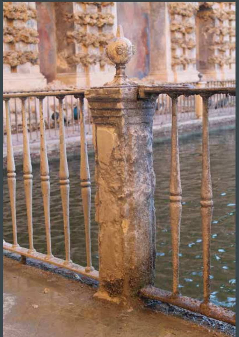
Figura 13. Pilar n° XXI devastado por los fenómenos desencadenados por la acción directa y continuada del agua del chorrón.
