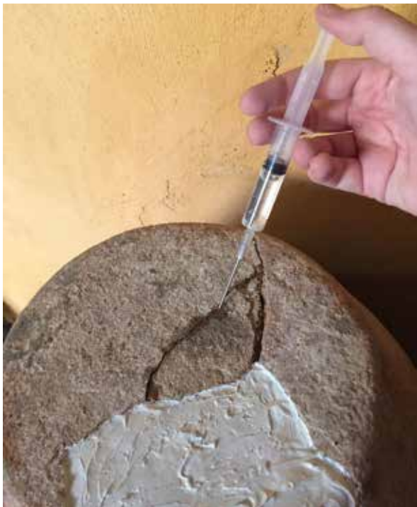
Figura 9. Inyecciones de silicato de etilo en fisuras.
