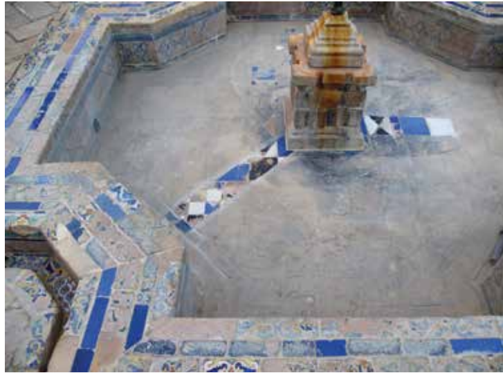
Figura 27. Fuente este. Capturas de limpieza del material cerámico, ejecutada por procedimientos mecánicos y químicos. (Crest Arte)
