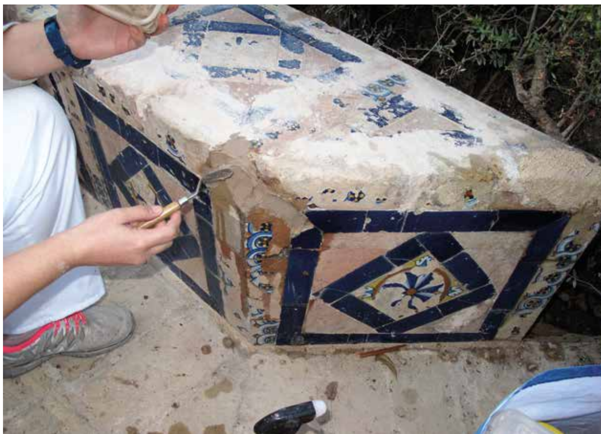
Figura 49. Banco de glorieta oeste. Proceso de rejuntado y sellados de oquedades con morteros coloreados de cal y teja. (Crest Arte)
