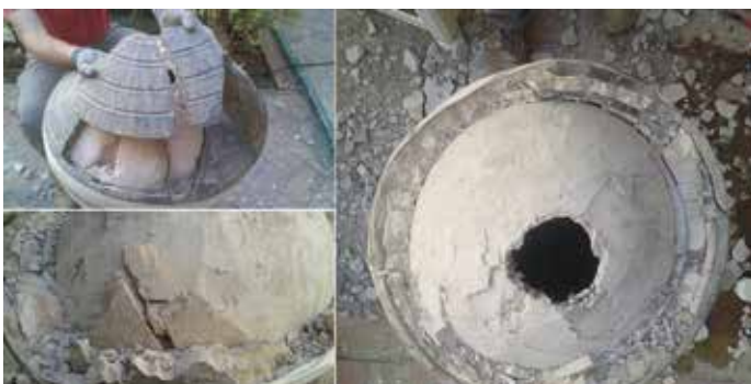
Figura 19. Detalles del sistema de montaje antiguo.
