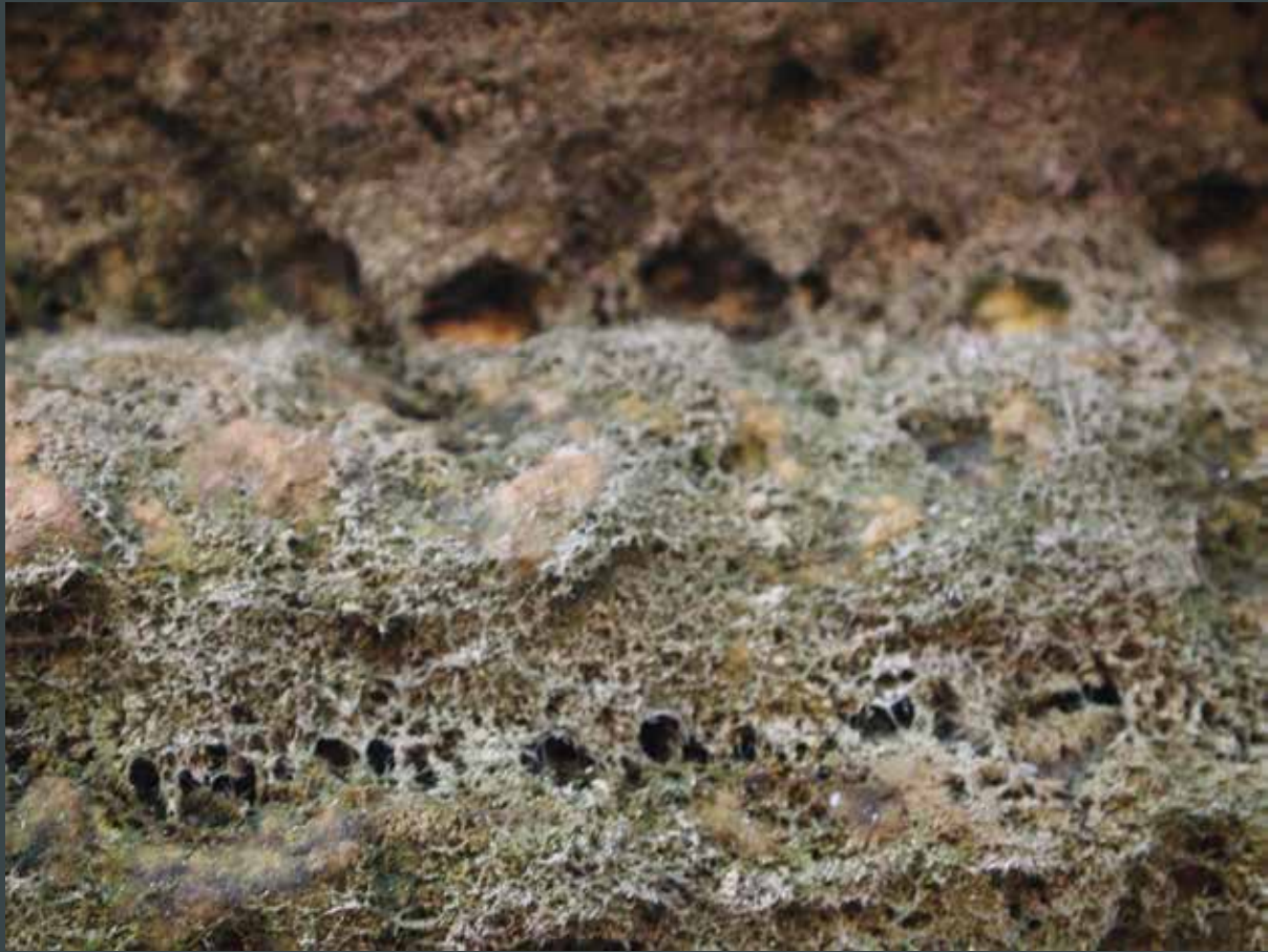
Figura 28. Detalle del manto biológico en el pedestal del grupo central. (foto Perla/Peña).
