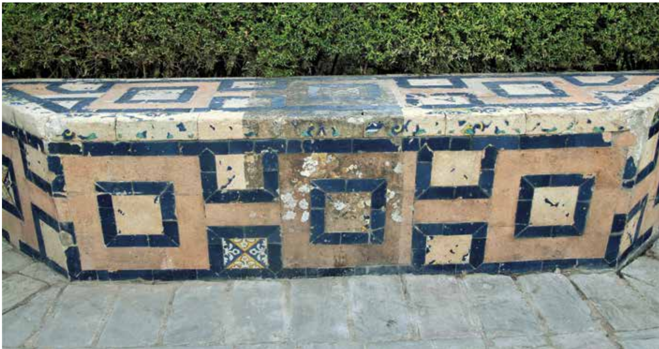
Figura 47. Banco de glorieta este. Proceso de limpieza. Testigo de suciedad ambiental y biocostras por líquenes. (Crest Arte)
