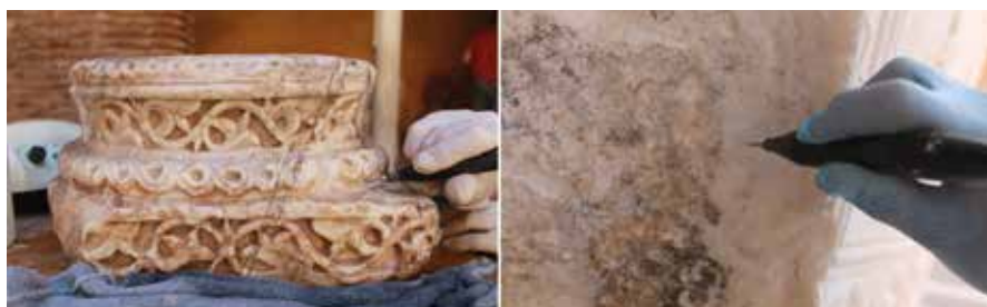
Figura 4. Tratamientos de limpieza de material pétreo con lápiz de ultrasonidos.
