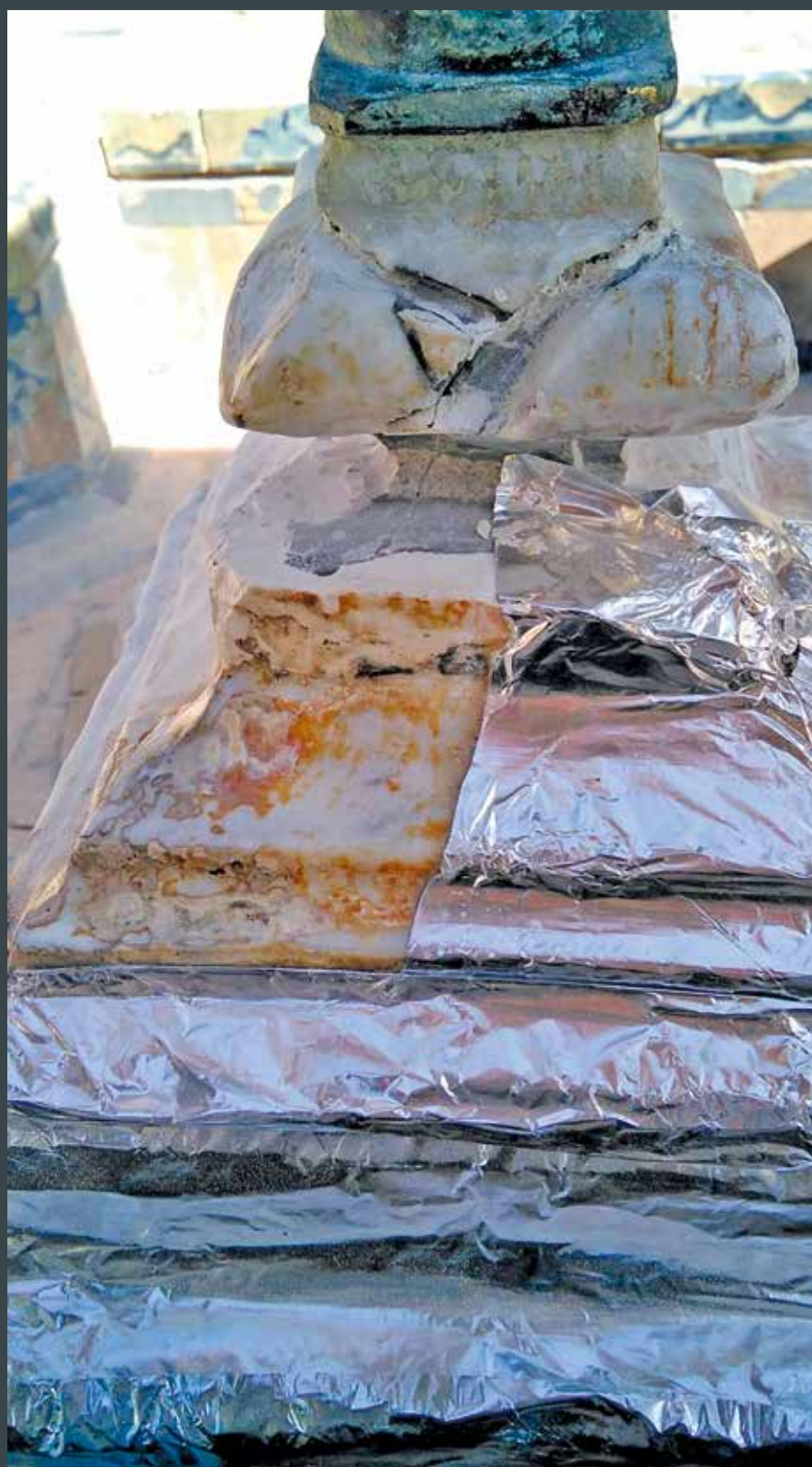
Figura 42. Fuente oeste. Proceso mixto de eliminación de zonas reconstruidas y de limpieza de carbonatos mediante papetas químicas a base de sales disueltas. (Crest Arte)
