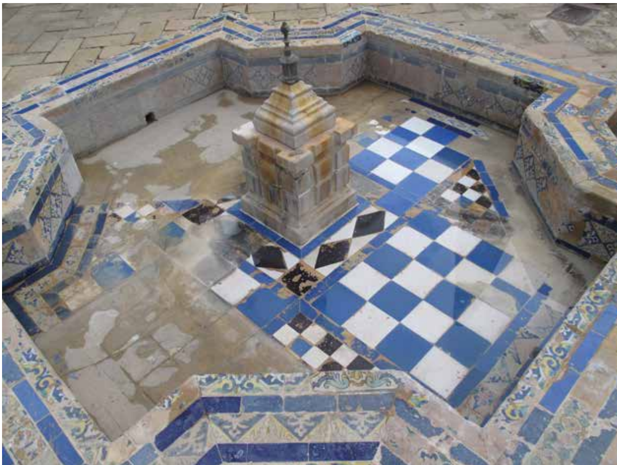
Figura 28. Fuente este. Desarrollo de la limpieza del material cerámico. (Crest Arte)
